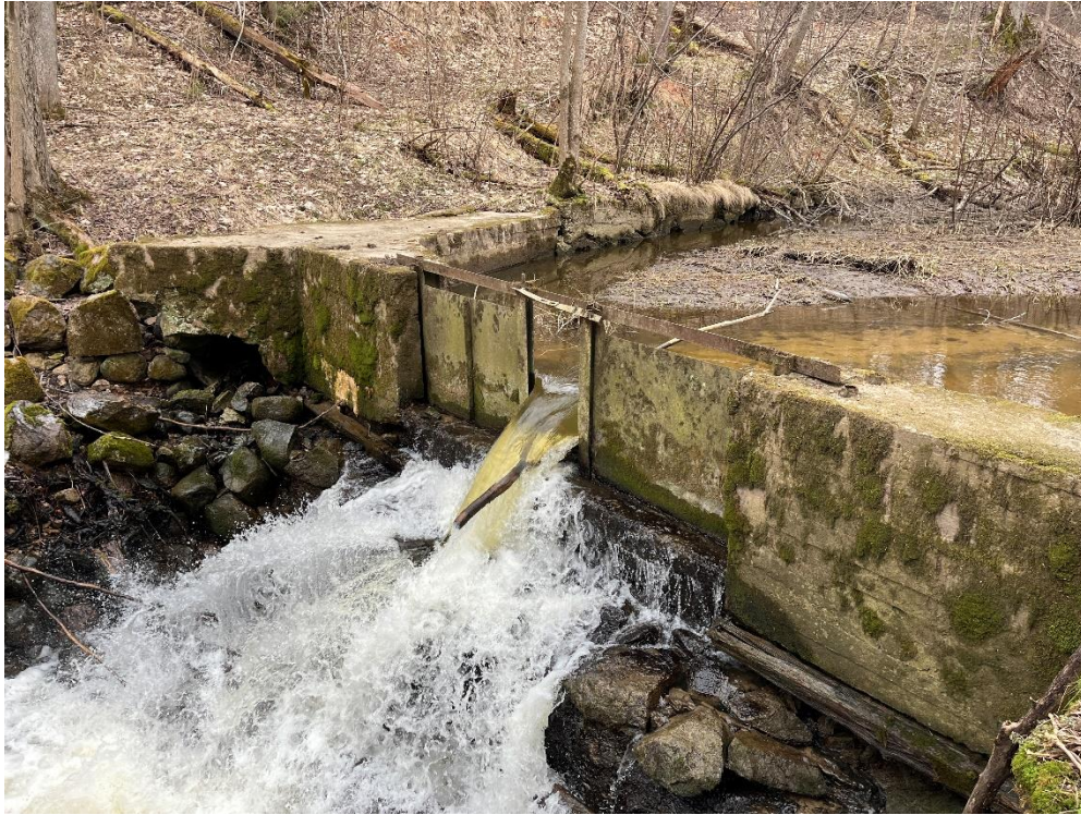
Joonis 2. Utria paisu betoonkeha on säilinud, kuid paisjärv mitte. Vee läbivool toimub keskmise kitsa ülevooluava kaudu.
